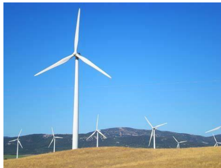
Figura 1. Aerogenerador de eixo horizontal
